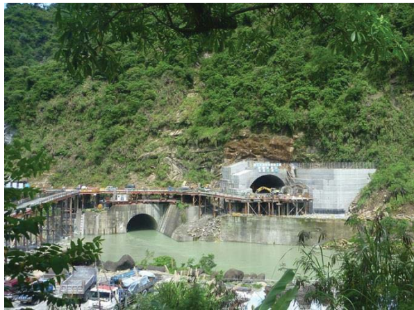
為減緩水庫砂淤的速率，於石門、曾文、南化等 3 座重要水庫，推動上游集水區保育減砂、中游導砂、庫區排砂，下游土砂回歸河道等整體防淤策略。(圖為曾文水庫防淤隧道工程新建工程；經濟部水利署提供)
