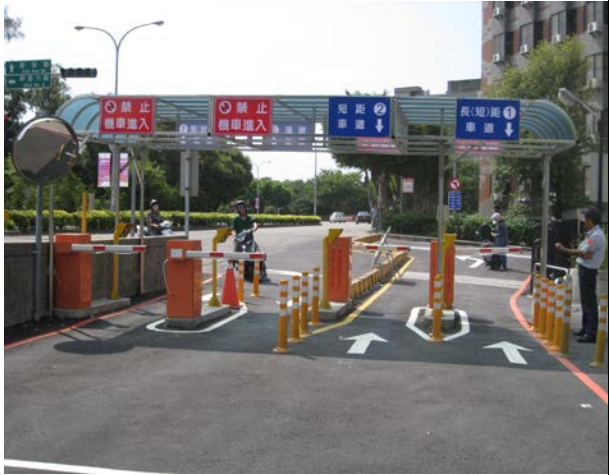
原有之柵道設備
