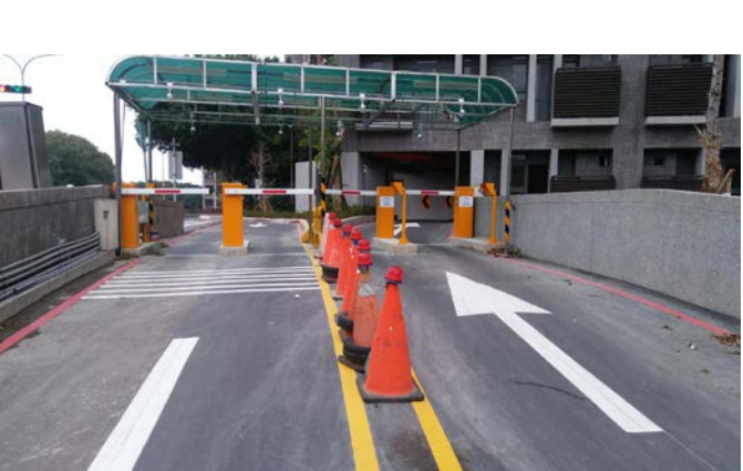
新裝置之柵道設備
