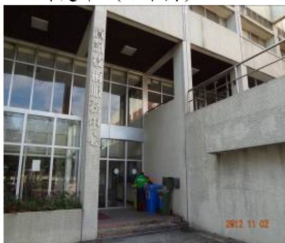
資訊管無障礙電梯預定位置
