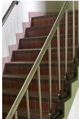
新增階梯防護緣
