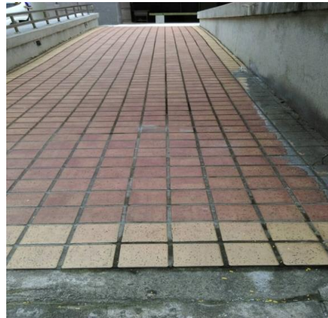
坡道地坪 (整修後)
