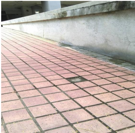
坡道地坪 (整修前)
